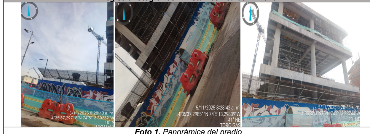
Foto 1. Panorámica del predio
